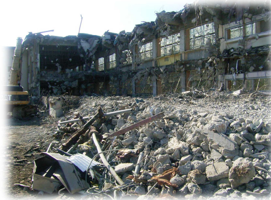
解体された中学校
