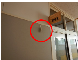
⑬ 普通教室棟 1F 用務員室前廊下
