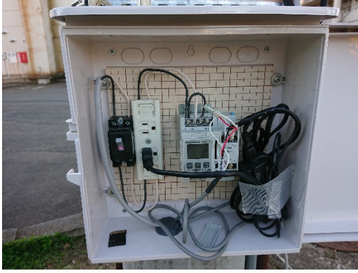
買電メーターに設置
