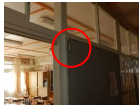
⑩ 管理棟 3F 普通教室前 廊下
