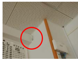
⑨ 管理棟 3F 普通教室内(天井表面)
