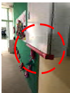
写真5 廊下の突起物の角に取り付けたゴム製のカバー
