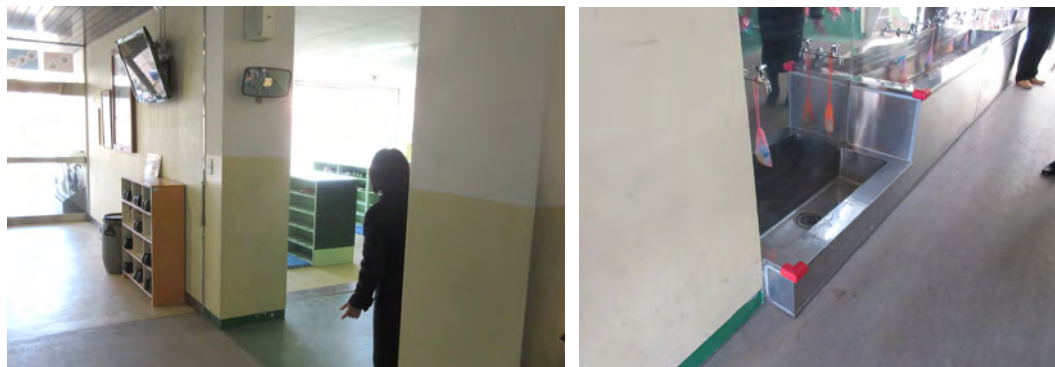
写真群 1. 曲がり角のミラー設置(左), コーナーガード設置(右)
