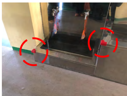
写真6 水洗い場の角に取り付けたゴム製のカバー
