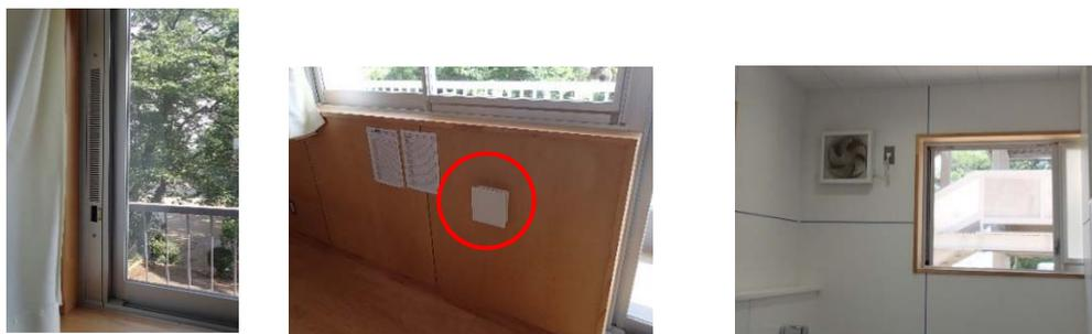
図 5-19 左からサッシ一体型手動開閉ガラリ，設備給気口，トイレ換気扇
