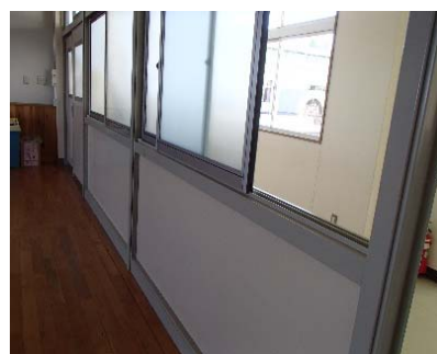
図 5-14 教室（廊下側）間仕切り壁（エコ改修により断熱化）
