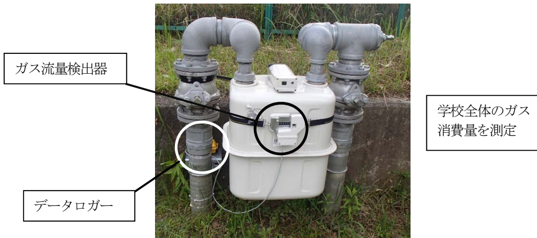
図 4-3 ガス使用量測定機器の設置状況
