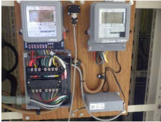
キュービクル内のパルス測定機器の設置状況
