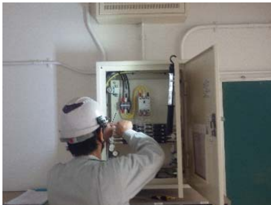
分電盤内の電圧・電流測定機器の設置状況
