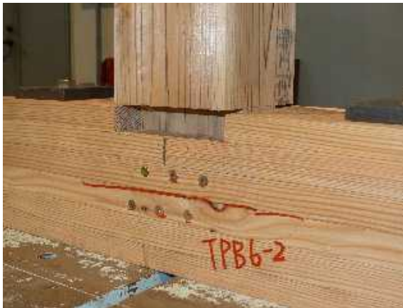
写真 2.2.5.4 土台の割れ、ビス頭のめり込み
