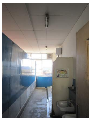
東校舎トイレ FL40W2本
