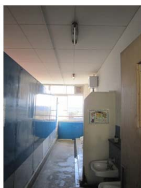
東校舎トイレ FL40W2本
