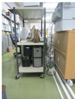
図 2-24 職員室のサーバー
