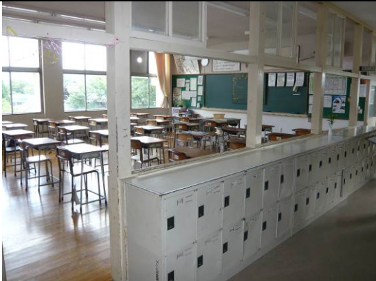
改修前(若狭町立三方中学校)
