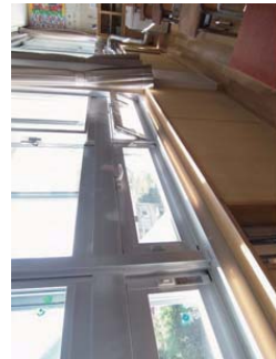
写真. 換気用窓の設置例
