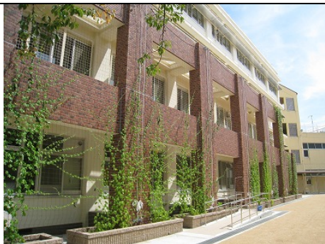
ネットの設置(神戸市立多聞東中学校)
