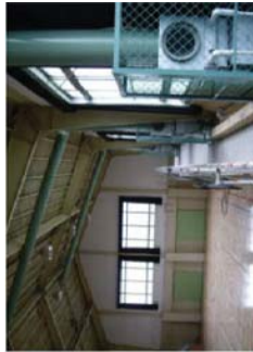
写真. 空気集熱式ソーラーシステムを導入した体育館
