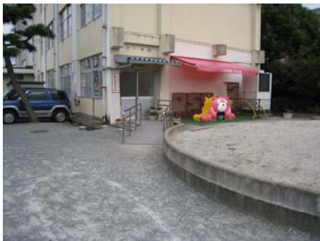
▲玄関：スロープ設置
