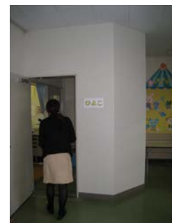
▲ 学校廊下に設置した防音壁
