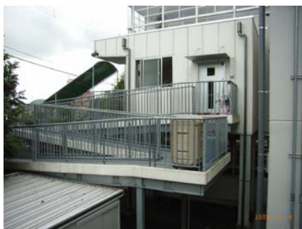
▲東側屋外階段を北側から見る
