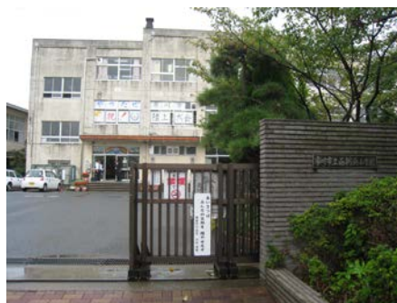
▲敷地外から正門を見る
