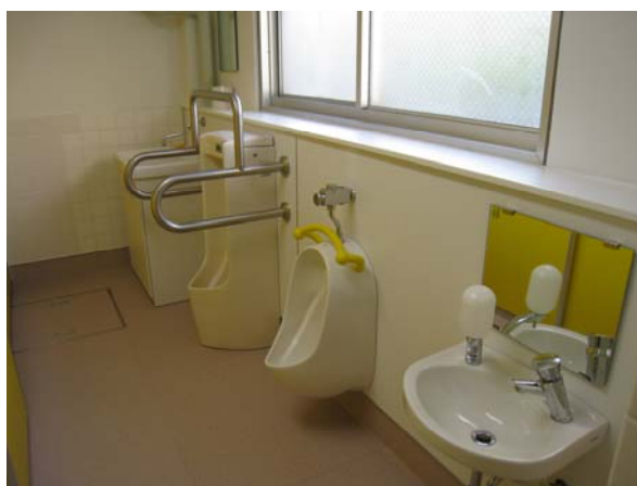
幼児用に改修したトイレの内部
