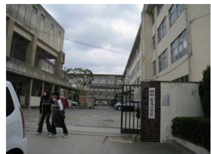
▲ 敷地外から正門を見る
