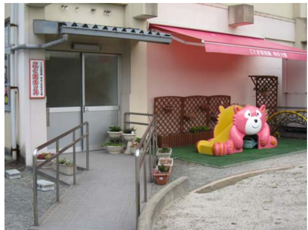
▲北門側から保育園分園玄関を見る
