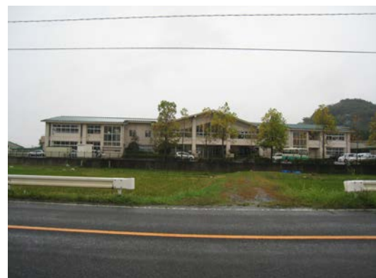
▲ 松島第二小学校全景
