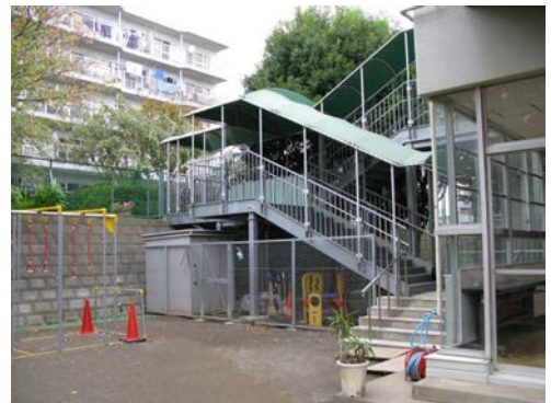
▲北側屋外階段で北側道路及び中庭へ降りる
