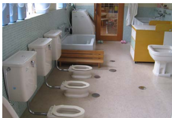
新設された幼児用トイレと沐浴室
