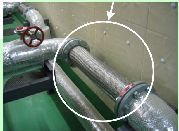
変位吸収継手の例
